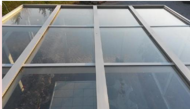
Chantier réalisé par la Sarl Da&Costa, menuiserie Alu
